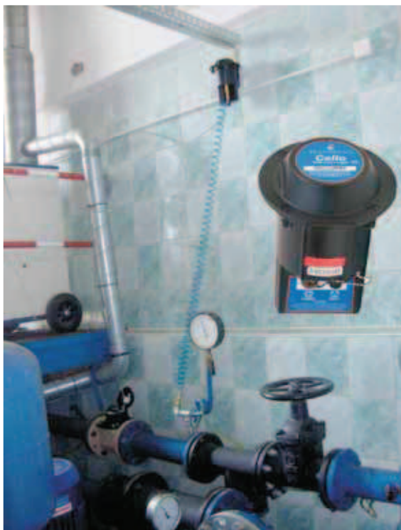
Dwuzakresowy impulsowy wodomierz śrubowy wody zimnej klasy B Woltex WE : DN 100m SUW „Północ”
