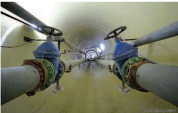
Fot. 7. Wnętrze rurociągu w trakcie budowy
