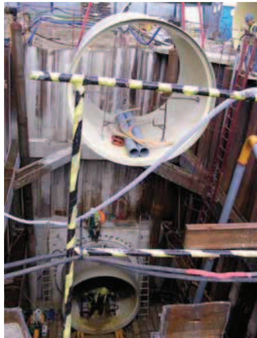
Fot. 9. Rury przed montażem
