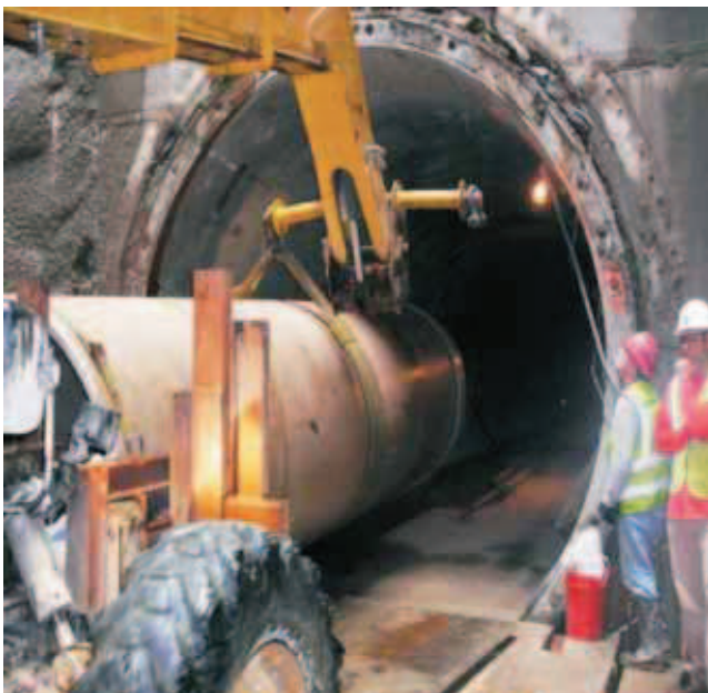
Fot. 5 i 6. Umieszczenie rury przewodowej w tunelu i montaż rurociągu
