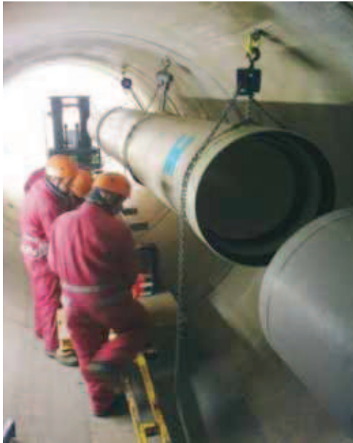
Fot. 8. Rzym – umieszczenie przewodów kanalizacji sanitarnej wewnątrz kanału deszczowego
