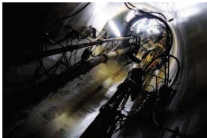
Fot. 4. Podparcia rurociągów wewnątrz tunelu
