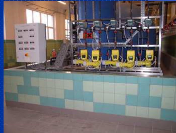
Stanowisko przygotowania i dozowania kuagulantu PAX
