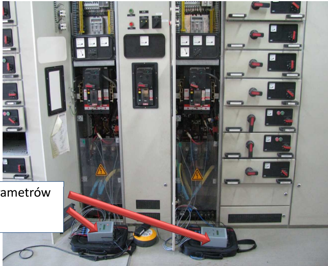
Fot. 2. Pomiar parametrów pracy rozdzielni elektrycznej R1 na terenie WOŚ
